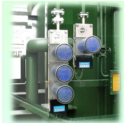
■ SC型環境調和ブリーザ 大気の吸湿呼吸器で、変圧器のコンサバーター内へ流入する大気をシリカゲルを使って湿度調整します。再生型エコブリーザーです。
