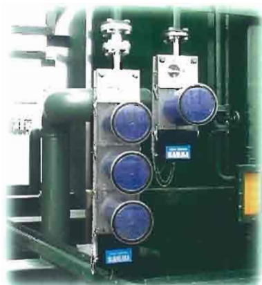
■ SC型環境調和ブリーザ 大気の吸湿呼吸器で、変圧器のコンサベーター内へ流入する大気をシリカゲルを使って湿度調整します。再生型エコブリーザーです。
